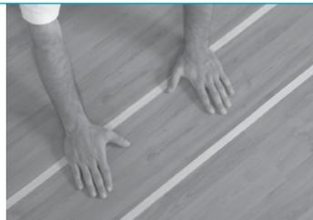
Com lápis ou caneta, trace na régua a ser substituída uma reta no sentido longitudinal e 2 retas nas diagonais, formando um X.
