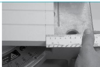
Após o corte, guarde o pedaço pequeno que sobrou, que deve ter um lado cortado em 45° e outro lado em 90°, pois esta peça será usada no acabamento de topo do rodapé.
