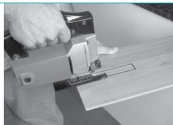
Para a retirada do pedaço cortado, utilize um formão. Lembre-se de deixar no mínimo 10 mm ao redor do elemento para a expansão do Durafloor já instalado.
