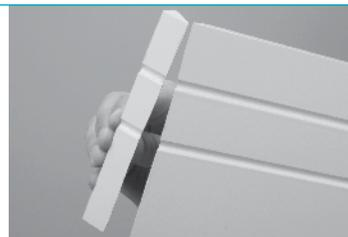
Vire a serra num ângulo de  $45^\circ$  e corte um pedaço da barra de rodapé de onde já foi retirado o acabamento de topo. Após o corte, a parte da frente do rodapé deve ser maior que sua base.
