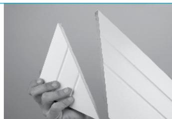
Vire a serra num ângulo de 45° e corte um pedaço da barra de rodapé de onde já foi retirado o acabamento de topo. Após o corte, a parte da frente do rodapé deve ser maior que sua base.
