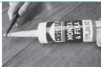
Coloque o tubo de cola na pistola aplicadora. Aplique a cola em linhas diagonais na face do rodapé que ficará junto à parede.
