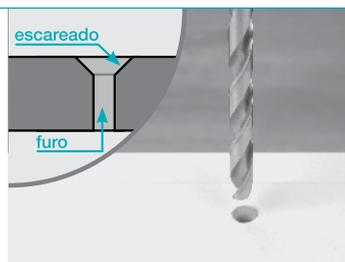
A distância máxima entre as furações deve ser de 60 cm. No caso de rodapés com 20 cm de altura, alterne a furação (em cima e embaixo) para melhor fixação.
